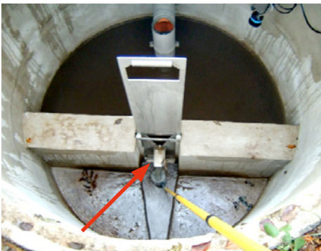
Bild 14.11: Probenahmestelle am Überlauf-Staubblech
