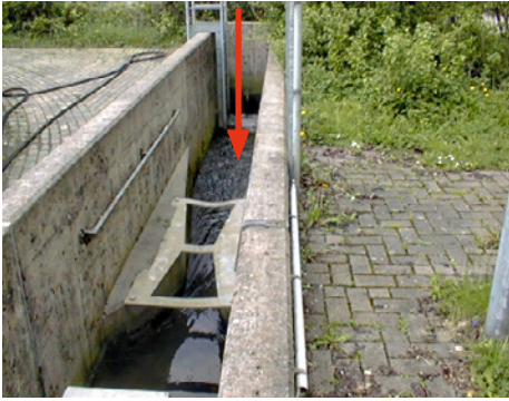
Bild 14.7: Probenahmestelle nach der Abflussmesseinrichtung
