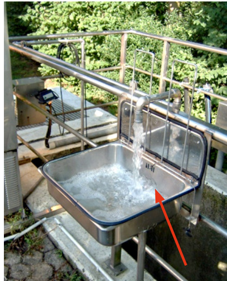
Bild 14.14: Probenahmestelle an Bypassleitung
