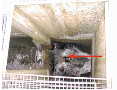
Bild 14.8: Probenahmestelle am Überlauf-Staubblech
